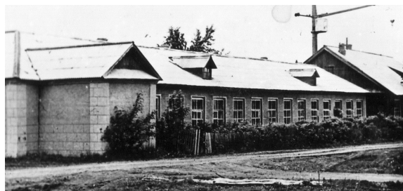
Каменное здание, построенное в 1963 – 1964 гг.
