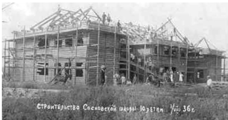
Строительство Сосновской средней школы, 1936 г.
