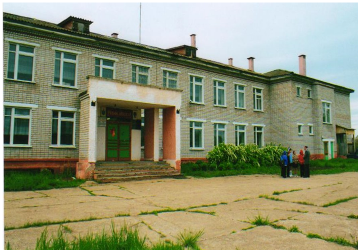
Современное здание МКОУ ООШ д. Нижние Шуни
