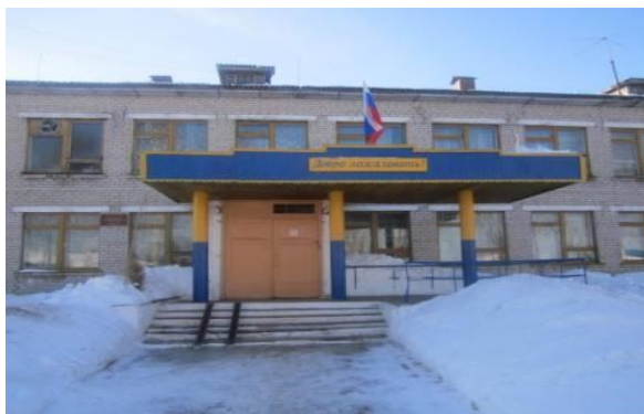
Современное здание МКОУ ООШ дер. Дым-Дым Омга
